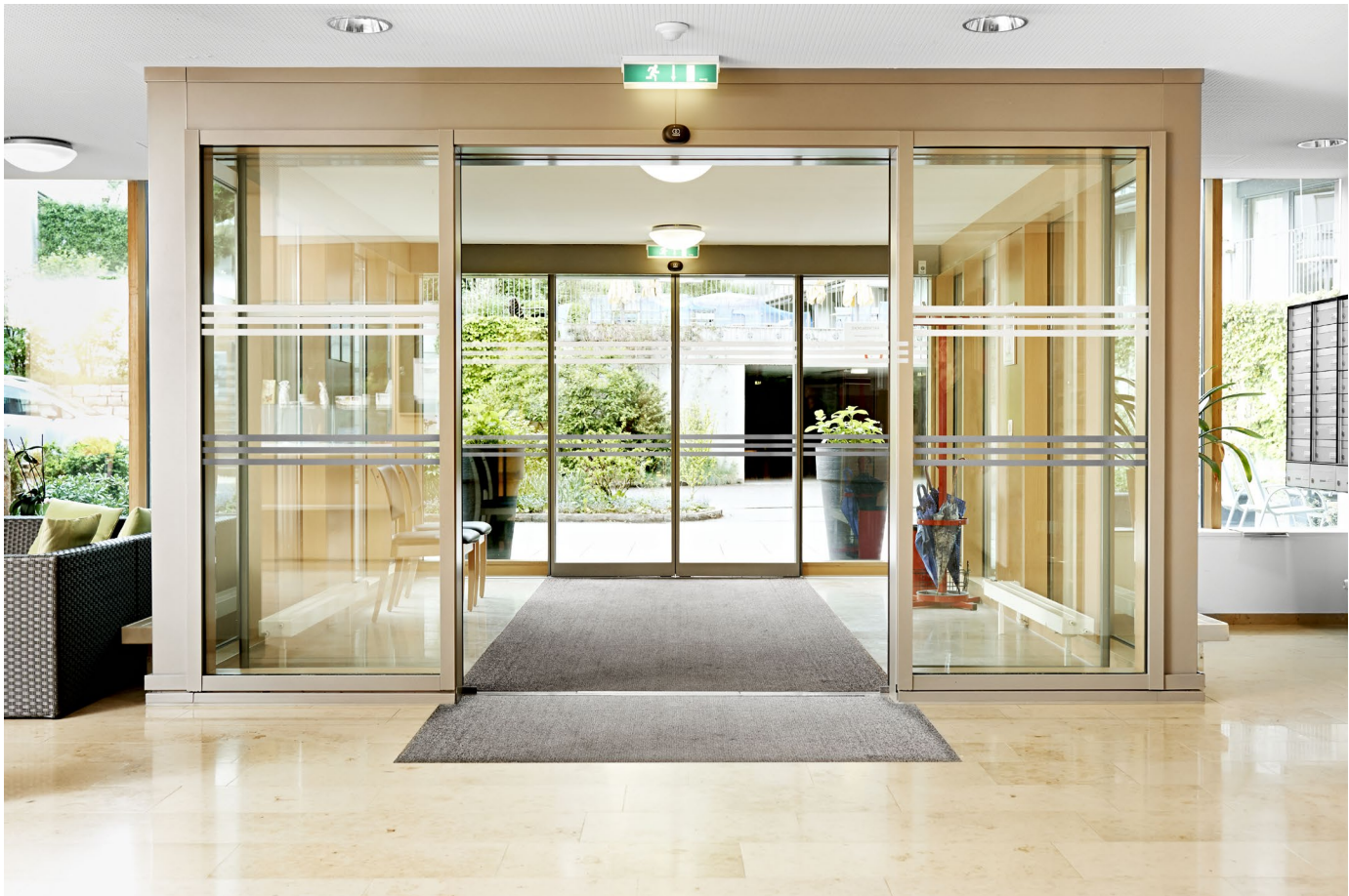
Abbildung 1 Helle sowie dunkle Markierungen auf Glaselementen
