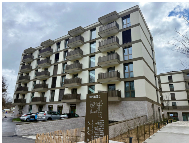
MIC de Marly, Route de l'Ancienne Papeterie in Marly
